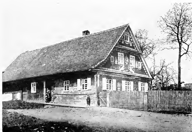
24. Blockhaus mit Silberschieferverkleidung, Eila im Frankwald, Oberfranken
